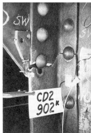
Gambar 5.11(b) : sambungan pada struktur rangka, profil siku.
