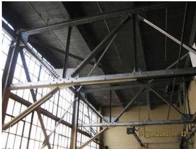
Gambar 5.1 : Struktur rangka atap dengan alat pengikat paku keling (rivet) Sumber: Ir. Thamrin Nasution, Departemen Teknik Sipil, FTSP. ITM, "MODUL KULIAH STRUKTUR BAJA 1"
