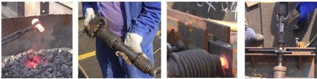
Gambar 5.6 : Cara menginstalasi paku keling, dengan menggunakan pneumatic hammer .
