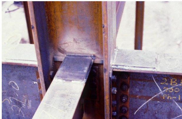
Gambar 5.4 : Alat pengikat dari las (welding). Sumber : AISC Presentation, dalam Thamrin Nasution
