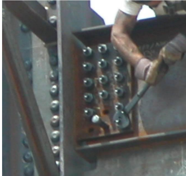
Gambar 5.9 : Baut dikencangkan dengan tangan.
